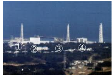
約40°離れた上空から撮影した、東京電力福島第一原子力発電所。左から1、2、3、4号機＝18日午後1時45分、共同通信社ヘリから
