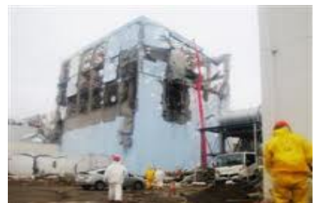
生コン圧送機を使用した福島第1原発4号機への放水作業＝22日午後（東京電力提供）
