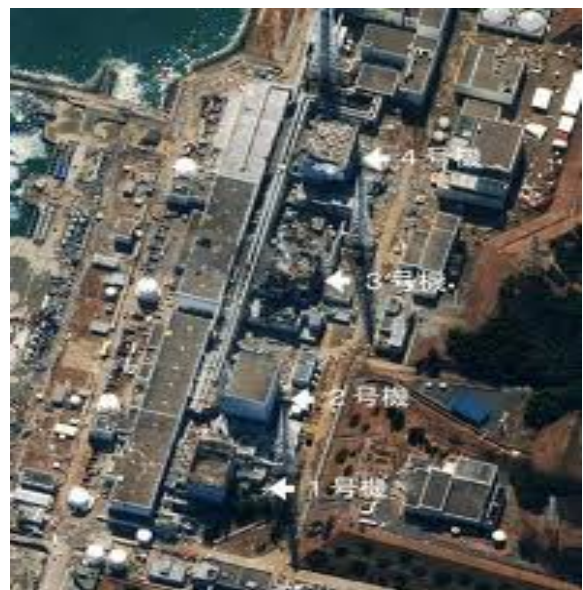
17日午前10時55分（日本時間）に撮影された東京電力福島第一原発の衛星写真。 （上から）屋根が骨組みだけとなった4号機、水蒸気のようなものが出る3号機と2号機、屋根部分が壊れた1号機（デジタルグローブ・ISIS提供・共同）
