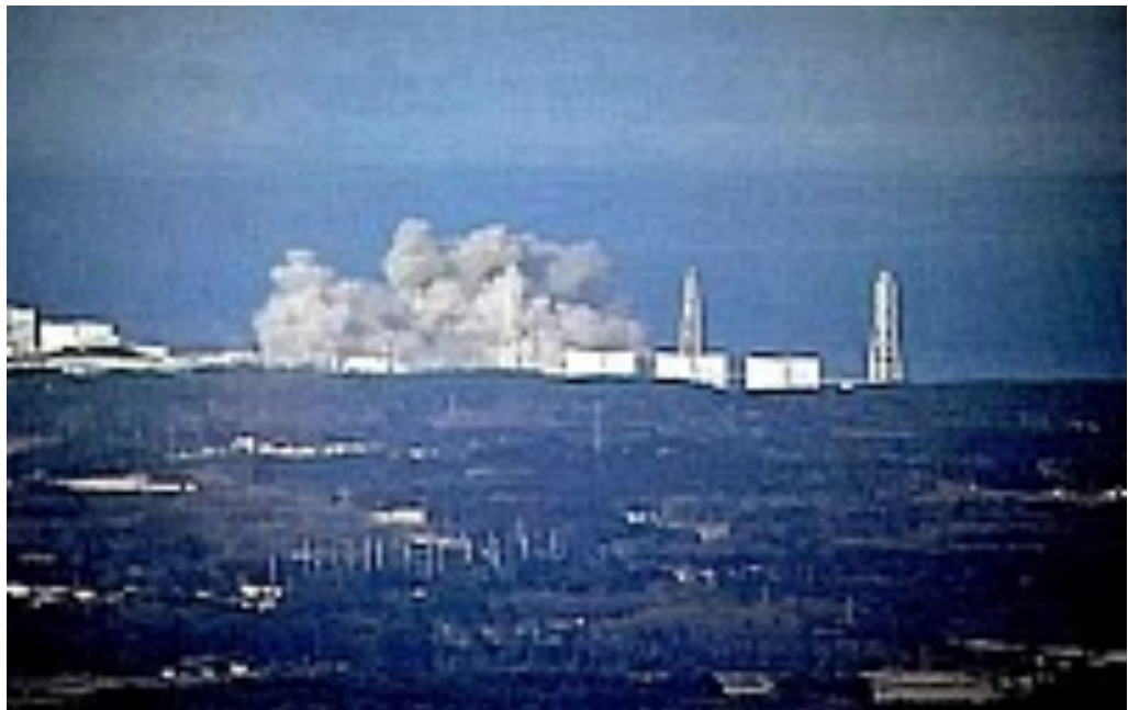
東日本巨大地震で被災し、運転を停止した東京電力福島第1原発。経済産業省原子力安全・保安院は、建屋内の中央制御室で通常の1000倍の放射線量を観測したと発表＝12日午前、福島県大熊町、双葉町
