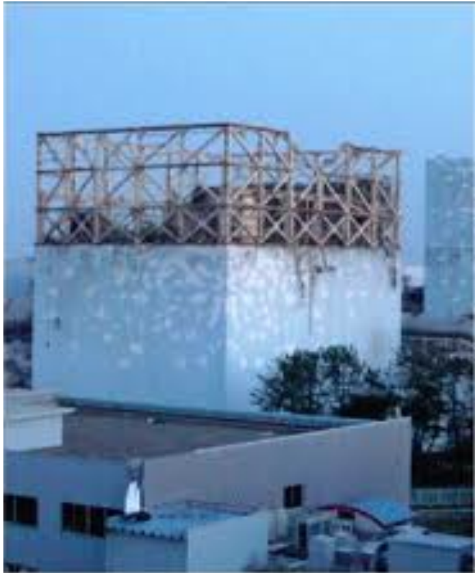
爆発した福島第一原発1号機の原子炉建屋（東京電力提供）
